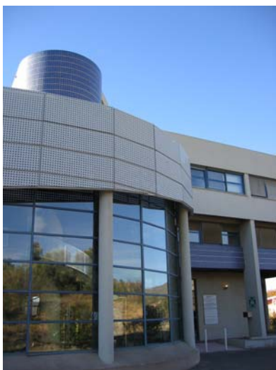
La Maison du Développement Industriel à Château-Gombert
